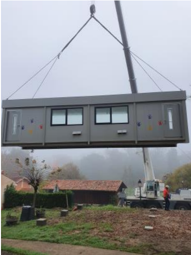
Livraison du bâtiment modulaire (préfabriqué) destiné à accueillir la quatrième classe
