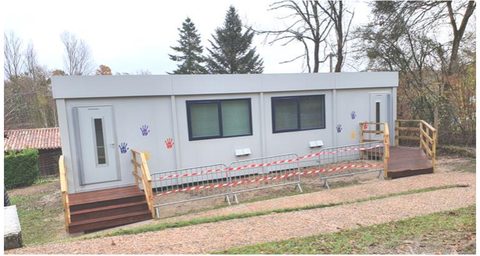
Le bâtiment modulaire qui accueille la quatrième classe après réalisation des accès et raccordement aux réseaux
